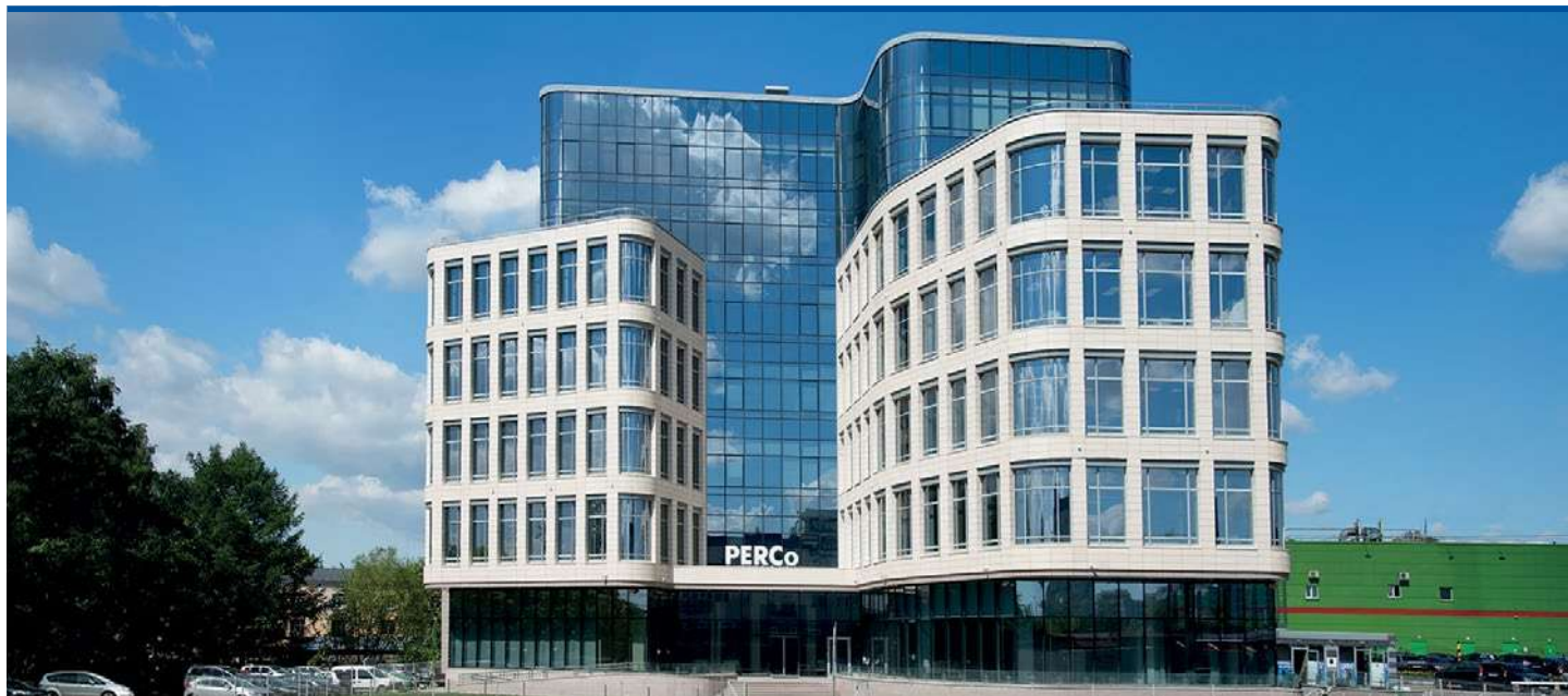
Главный офис PERCo
