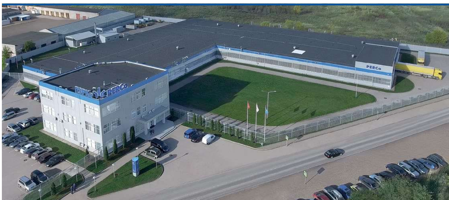
Завод в Пскове
